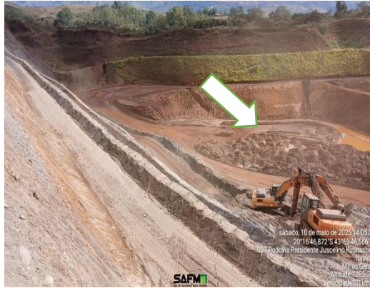
Figura 38 Fundo da cava sul e atual local de deposição do material explotado da obra emergencial em outros DM ANM.
