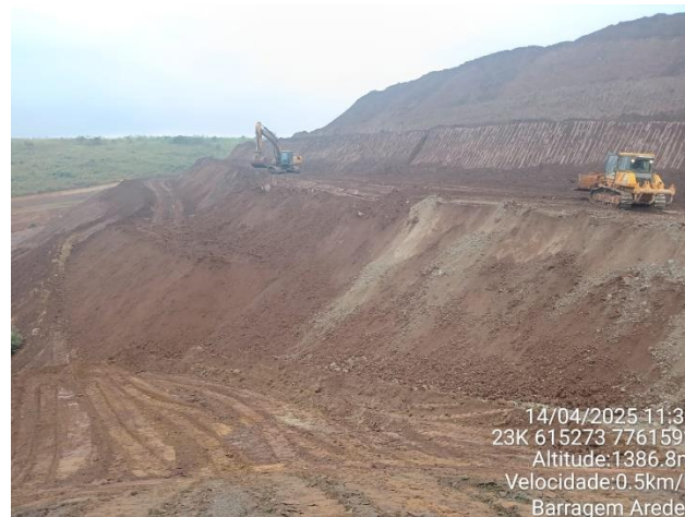
Foto18: basculamento de rejeito filtrado e rejeito da barragem central em bota-espera na praça 09.
