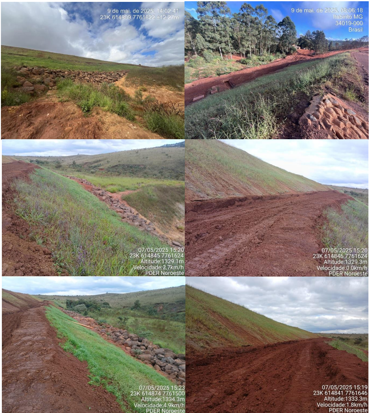
Foto 25: desenvolvimento vegetativo da hidrossemeadura na face do talude (cotas: 1330m a 1340m.).
