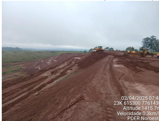
Foto18: basculamento de rejeito filtrado e rejeito da barragem central em bota-espera na praça 09.
