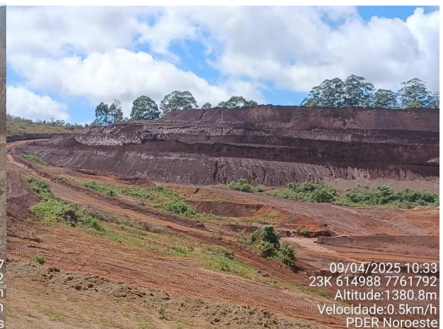
Foto18: basculamento de rejeito filtrado e rejeito da barragem central em bota-espera na praça 09.
