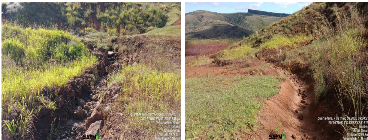
Figura 6-21: Fotografias do sistema de drenagem da Barragem Central ao longo do trimestre.
