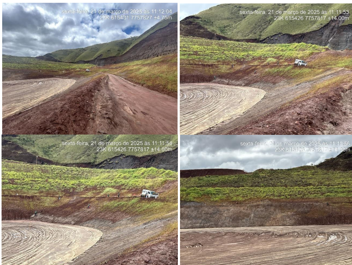
Figura 6-1: vegetação nos taludes remanescentes da Barragem Central.
