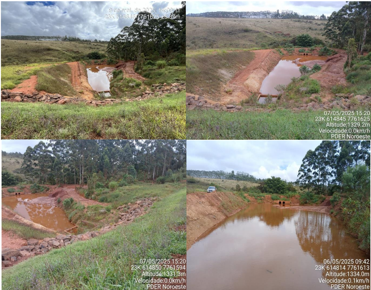
Figura 612: sump e dreno de fundo com saída de água límpida– Pilha Noroeste.
