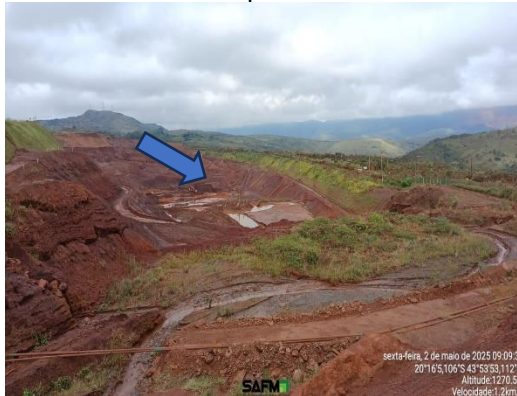
Figura 6-27: Cava do dique e tubo de drenagem (seta azul).
