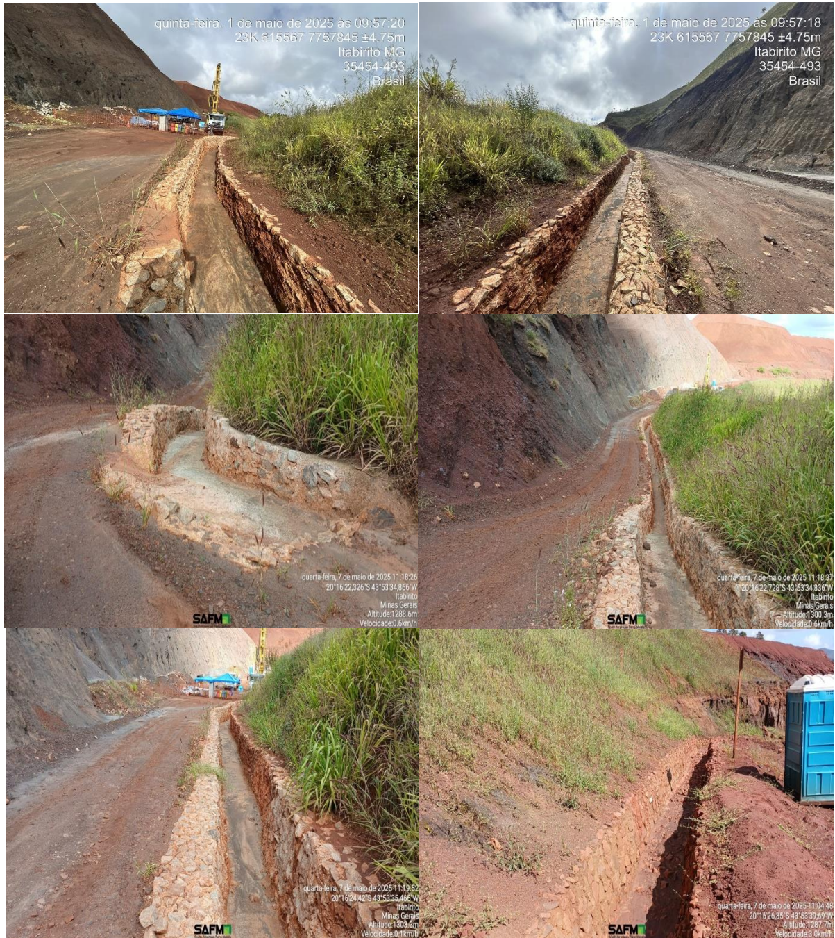
Figura 6-42: Canal de cintura da Barragem Central.
