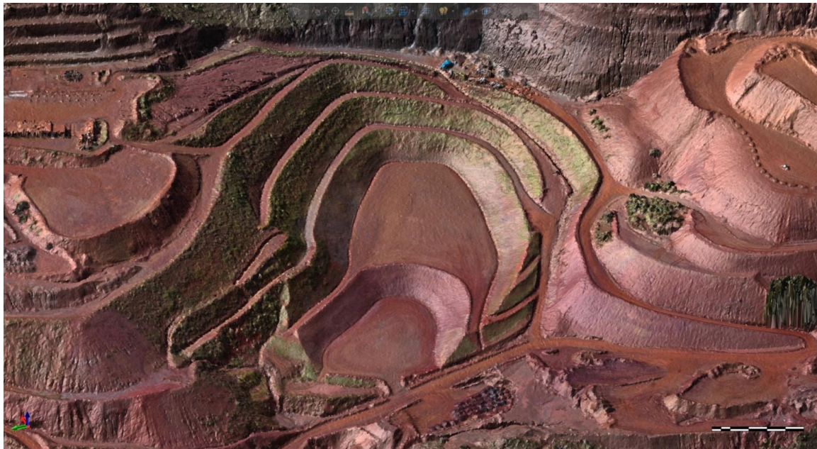
Figura 4: maio de 2025. Situação última da barragem após o fim das obras de descaracterização. Levantamento: 15/05/2025.
