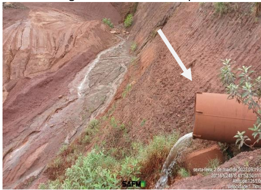
Figura 6-30: Tubo extravasor da água de montante da ITM.
