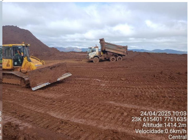
Foto18: basculamento de rejeito filtrado e rejeito da barragem central em bota-espera na praça 09.
