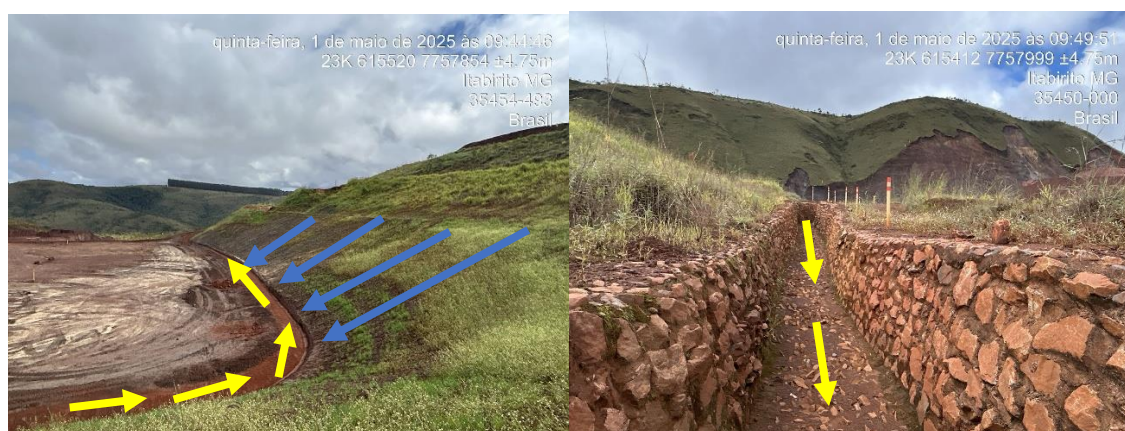
Figura 23: Direcionamento do fluxo pluvial do in situ remanescente na Barragem Central. Cor "vermelha": canal de cintura; cor "amarela": drenagem off set e cor "azul": drenagem de berma com sarjetas. Todo o fluxo é direcionado ao final para a cava do dique localizada a jusante da estrutura.
