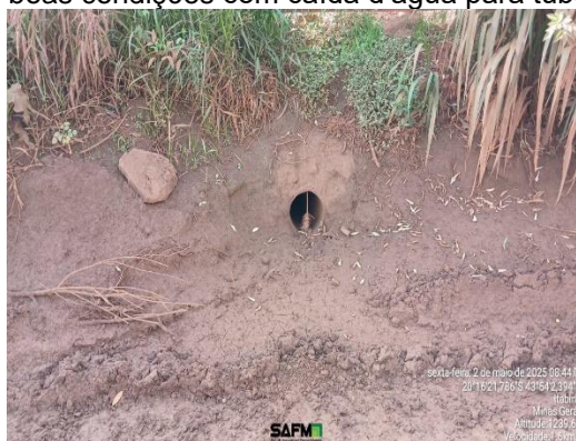
Figura 6-37: Entrada de um dos tubos oriundos da ITA-320 que desembocam na cava do dique totalmente desobstruído e funcional.
