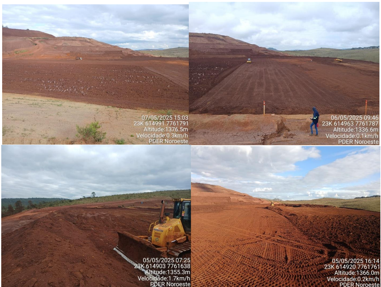
Figura 6: situação de momento da praça com controle e o início do processo de preparação para o alteamento das próximas camadas.
