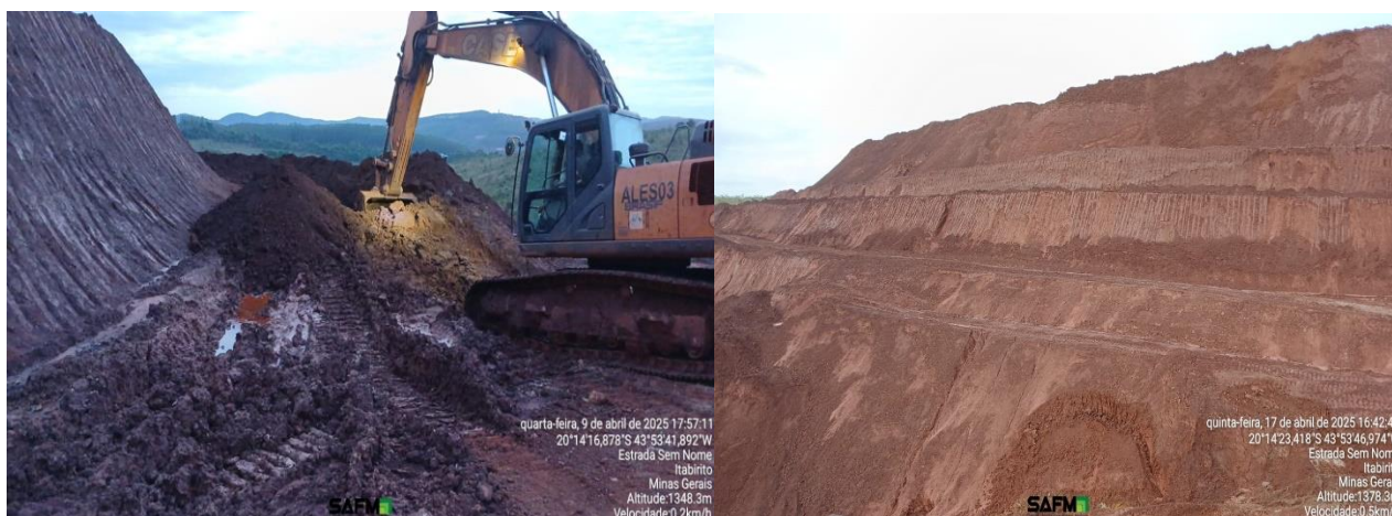
Foto17: adequação em face dos taludes da praça 10.
