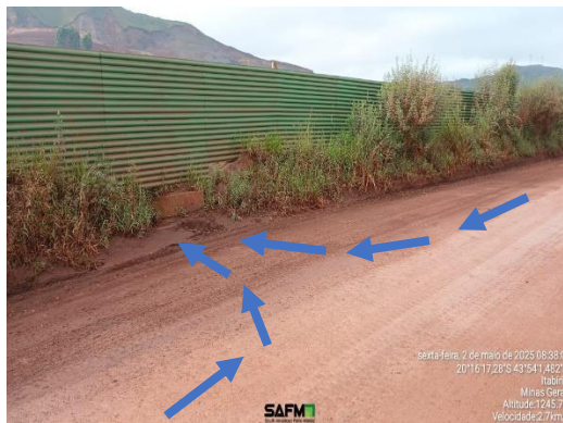
Figura 6-36: ITA-320 em boas condições com caída d'água para tubulação na Cava do Dique.
