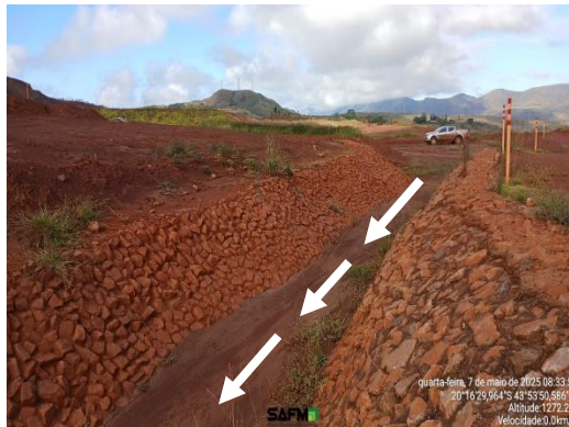
Figura 6-39: ombreira esquerda da antiga barragem de Aredes que culmina no desague na Cava do Dique.
