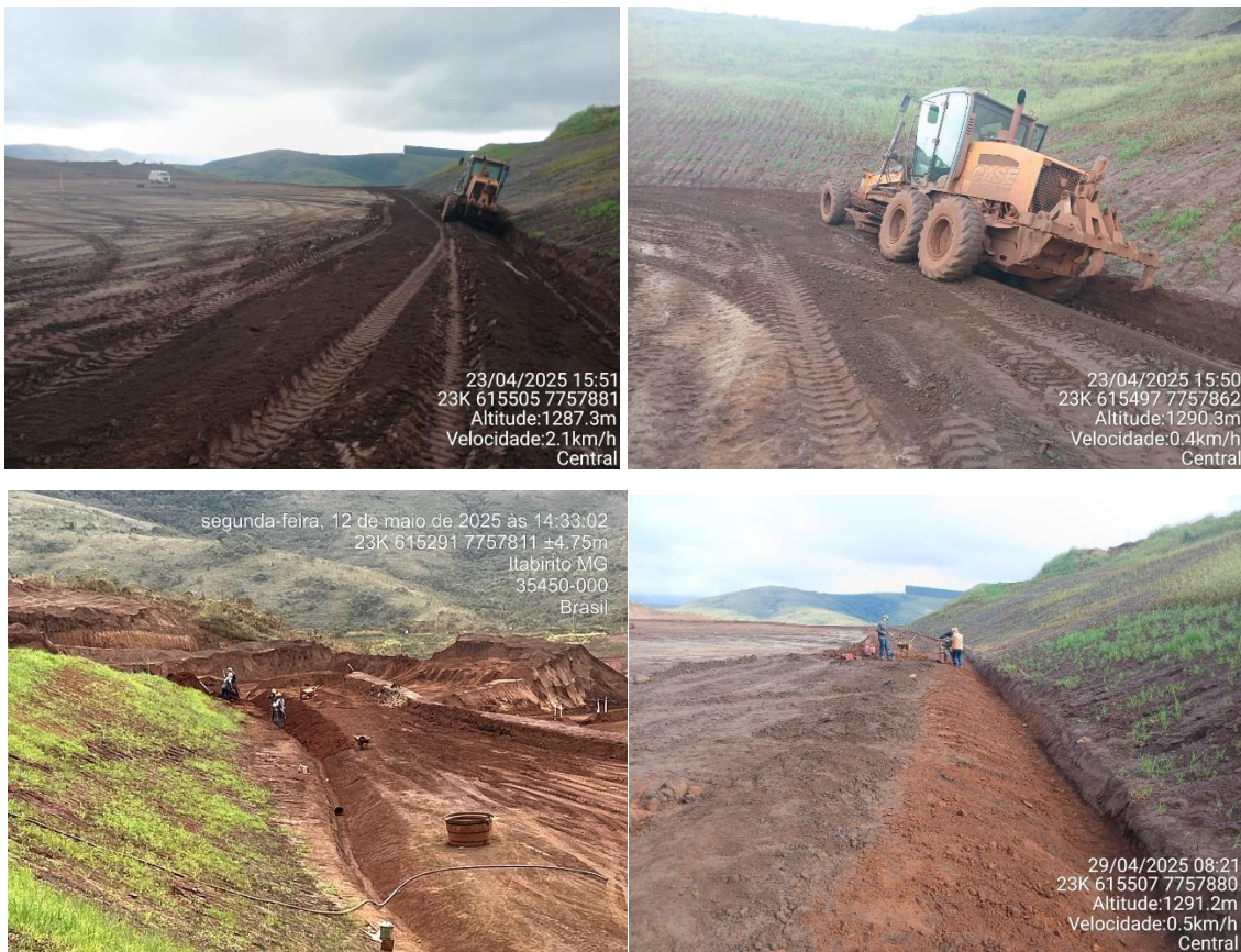
Figura 25: Finalização das obras das sarjetas nas bermas do remanescente in situ da Barragem Central.
