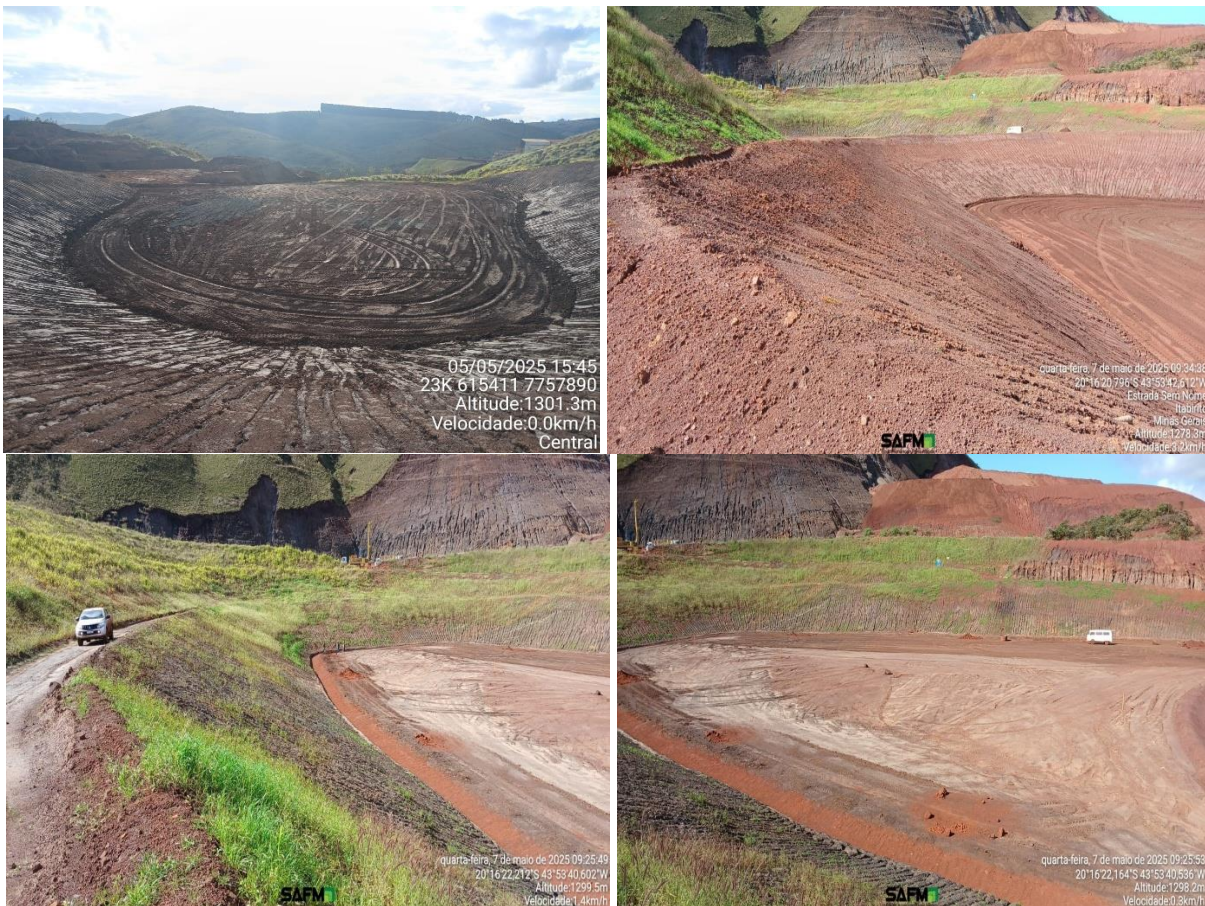
Figura 6-16: Situação geral da estrutura ao longo do trimestre.
