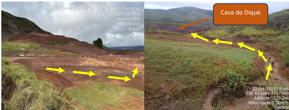
Figura 24: Direcionamento da água para saída da antiga estrutura da Barragem Central para cava do Dique a jusante por intermédio dos sistemas de drenagem.
