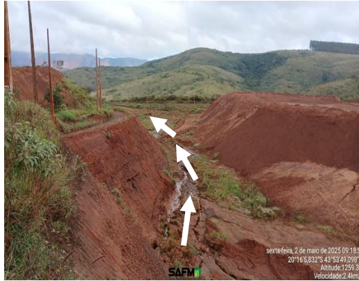
Figura 6-35: Drenagem oriunda do tubo extravasor da ITM indo em direção à Cava do Dique.
