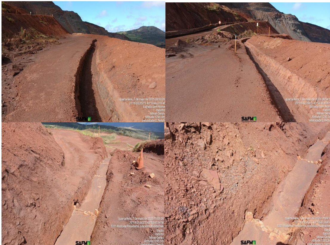
Figura 10: Canal off set após a finalização da obra de descaracterização.
