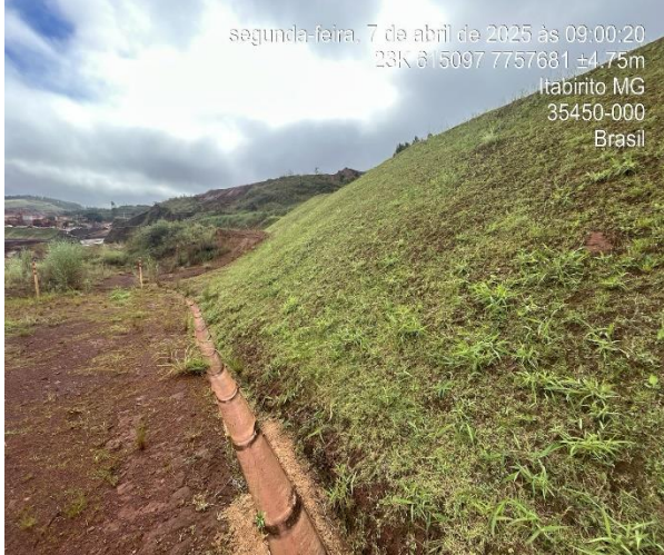
Figura 6-30: Fotografias do sistema de drenagem da Barragem Aredes ao longo do trimestre.
