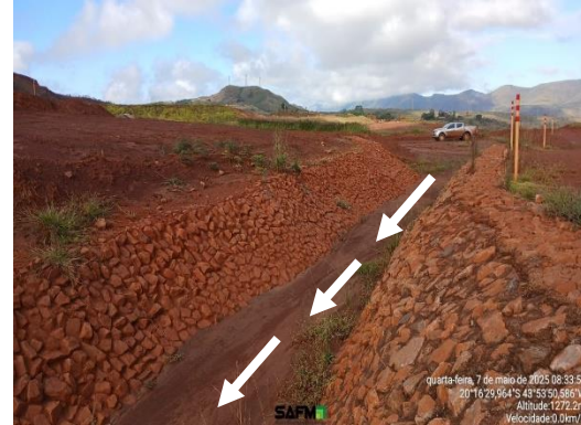
Figura 6-52: ombreira esquerda da antiga barragem de Aredes que culmina no desague na Cava do Dique.
