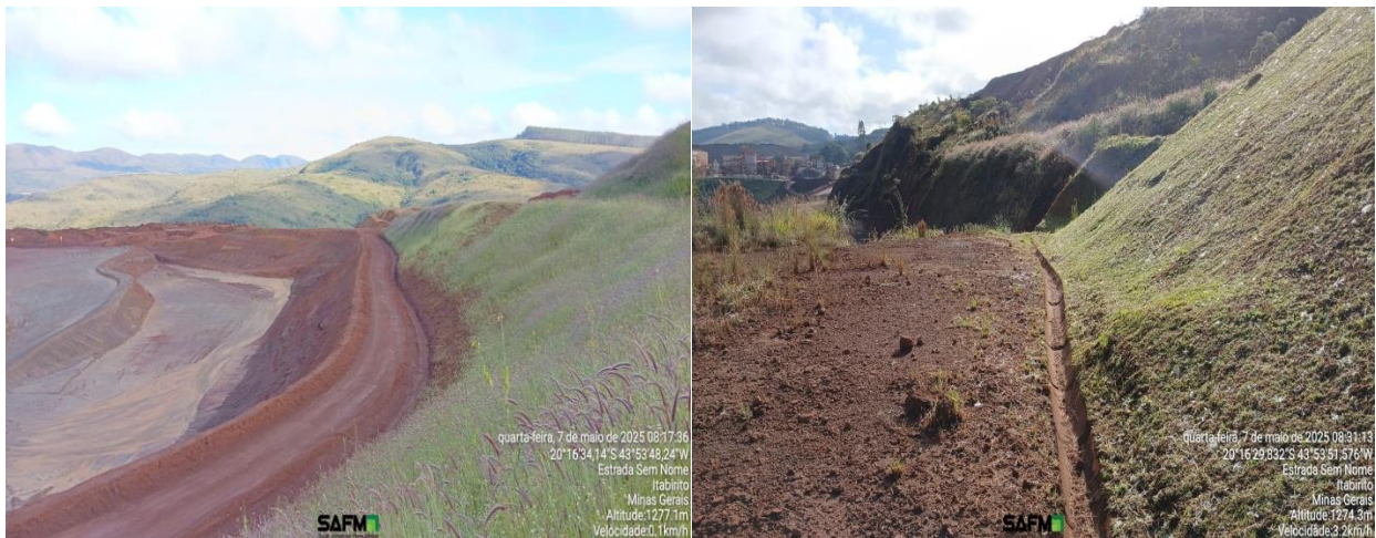
Figura 29: Talude remanescentes em boas condições e com vegetação devidamente plantada.
