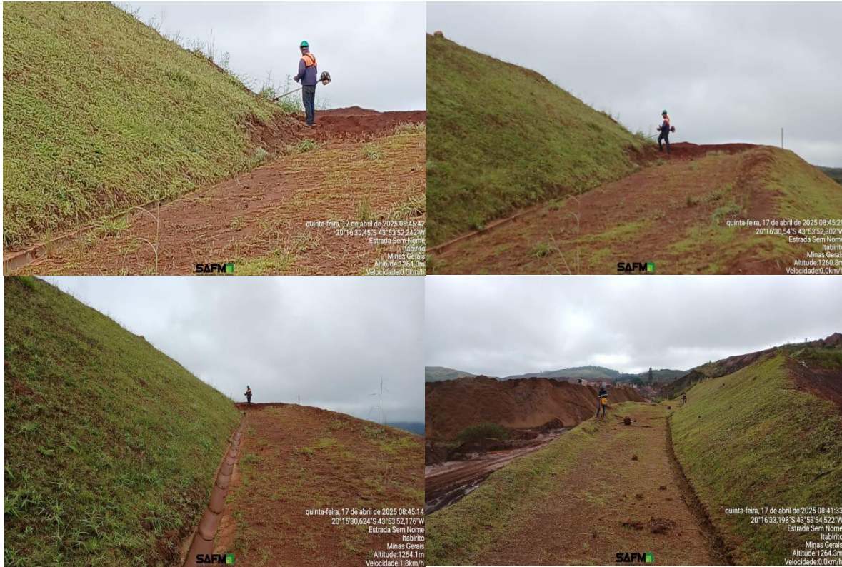
Figura 5: Manutenção nos taludes remanescentes da Aredes.
