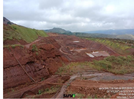
Figura 6-48: Condições da antiga cava laninha, atual expansão da cava do dique.
