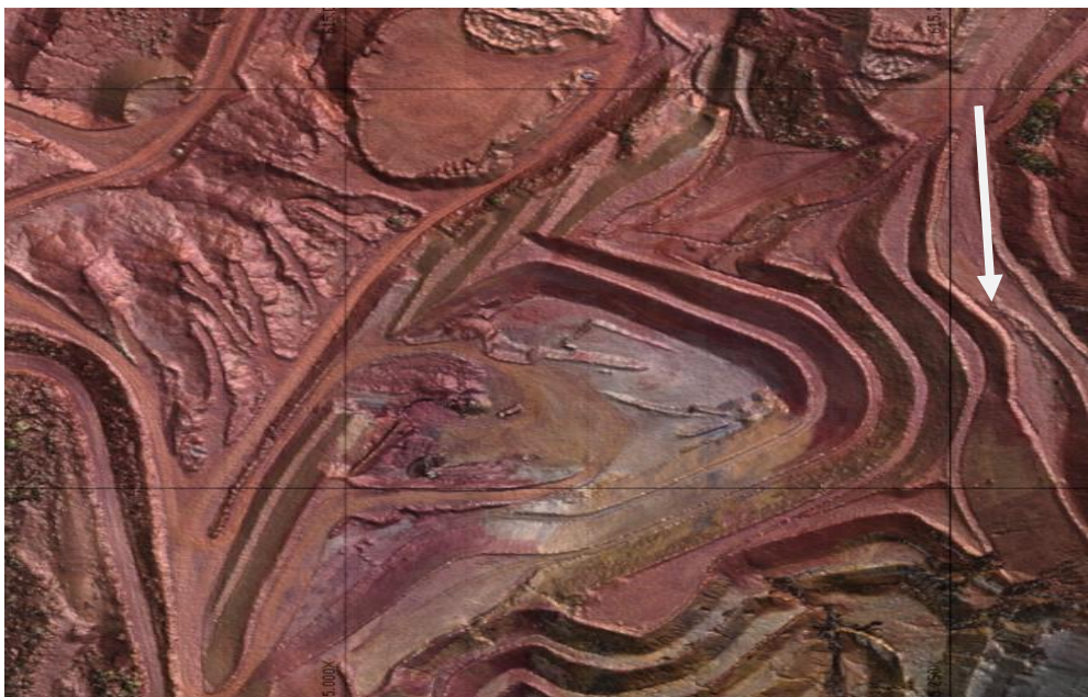
Figura 6-14: Localização do banheiro químico na antiga Barragem Aredes.
