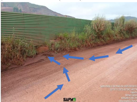
Figura 6-47: ITA-320 em boas condições com caída d'água para tubulação na Cava do Dique.
