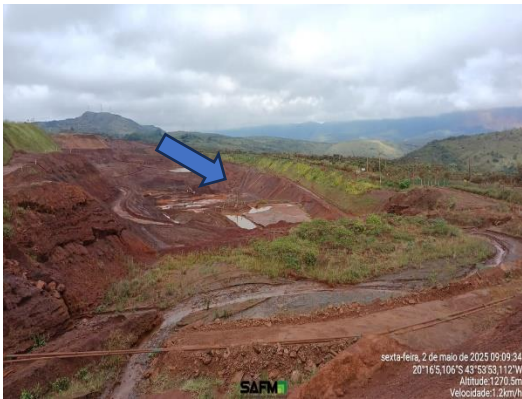
Figura 6-39: Cava do dique e tubo de drenagem (seta azul).
