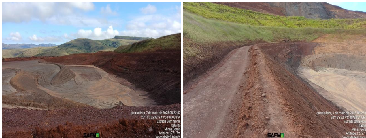
Figura 32: condição recente e última da barragem Aredes.
