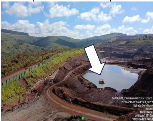
Figura 6-46: Fundo da cava do dique com a água pluvial sendo retida para aspersão interna.
