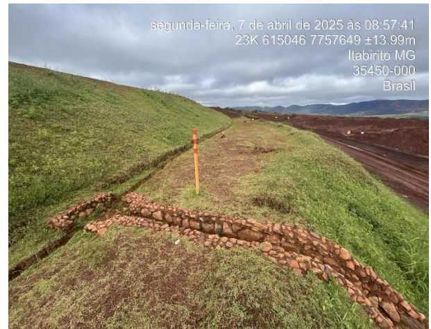
Figura 6-30: Fotografias do sistema de drenagem da Barragem Aredes ao longo do trimestre.
