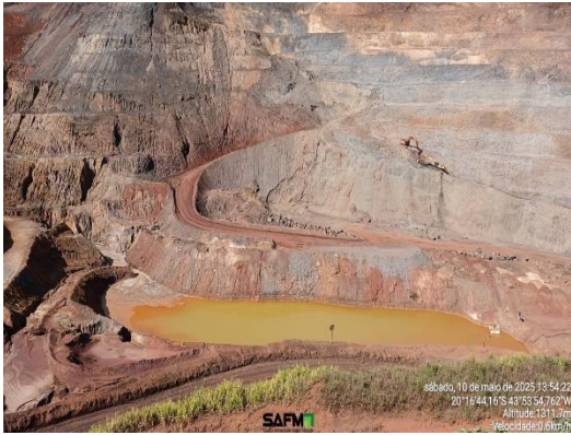
Figura 6-38: Fundo da cava sul.
