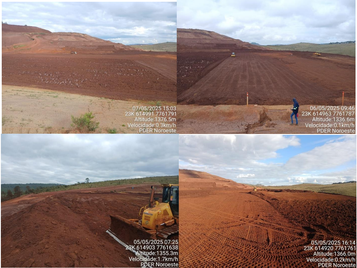
Figura 6: situação de momento da praça com controle e o início do processo de preparação para o alteamento das próximas camadas.
