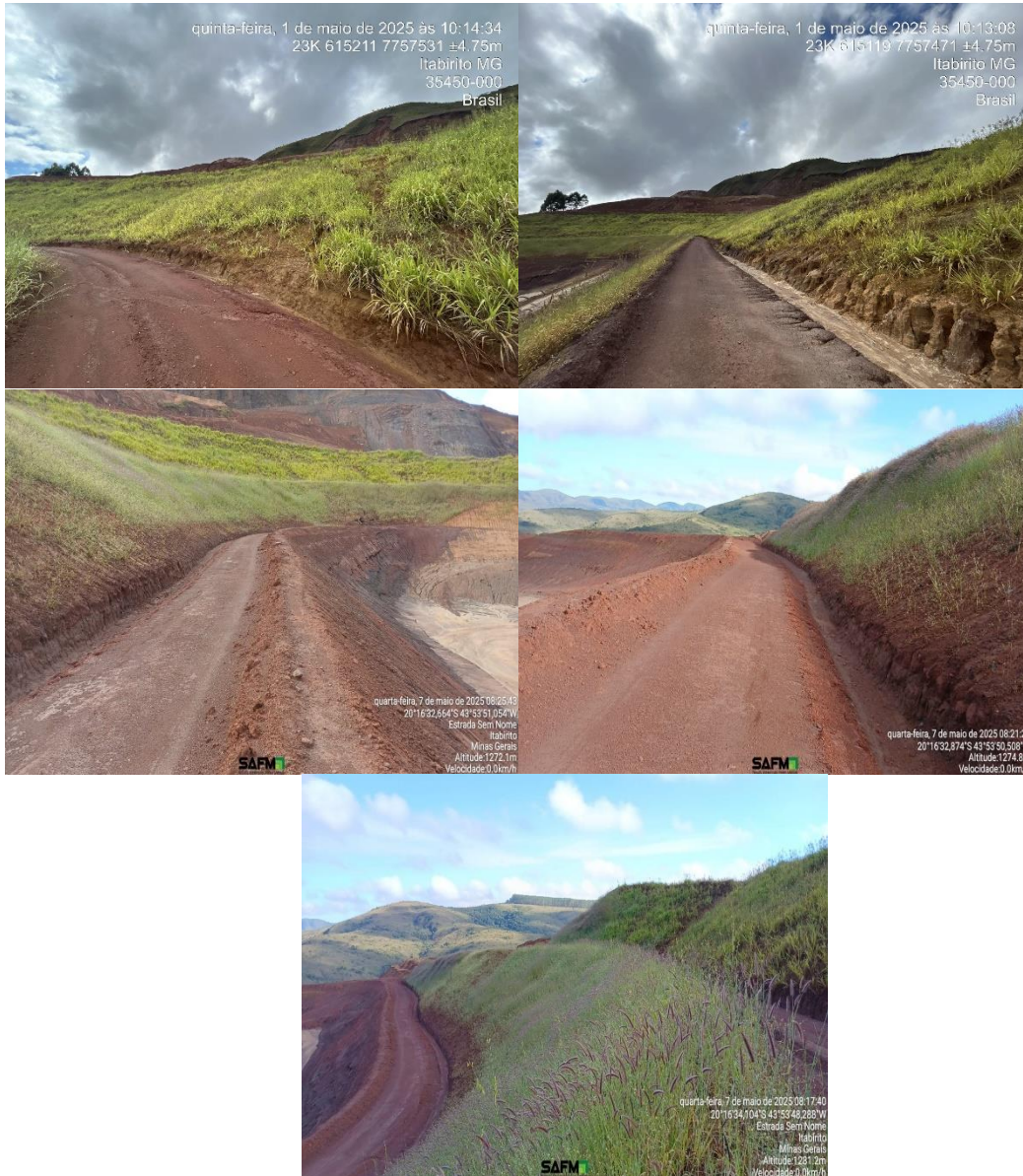
Figura 27: canaletas de solo apiloado nos taludes remanescentes.
