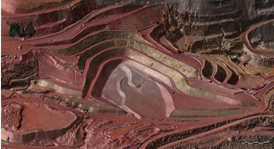
Figura 6: Situação da barragem após o término da descaracterização. Março de 2025.
