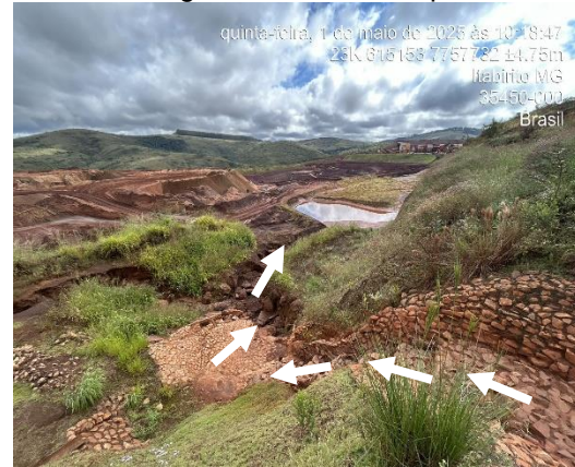
Figura 6-53: Saída da drenagem do extravasor principal da Barragem Aredes para o dique a jusante.
