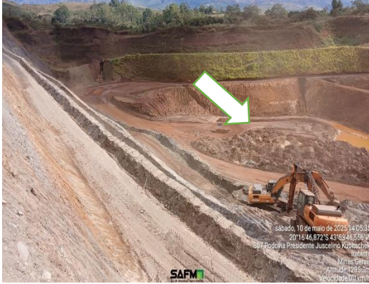
Figura 51 Fundo da cava sul e atual local de deposição do material explotado da obra emergencial em outros DM ANM.
