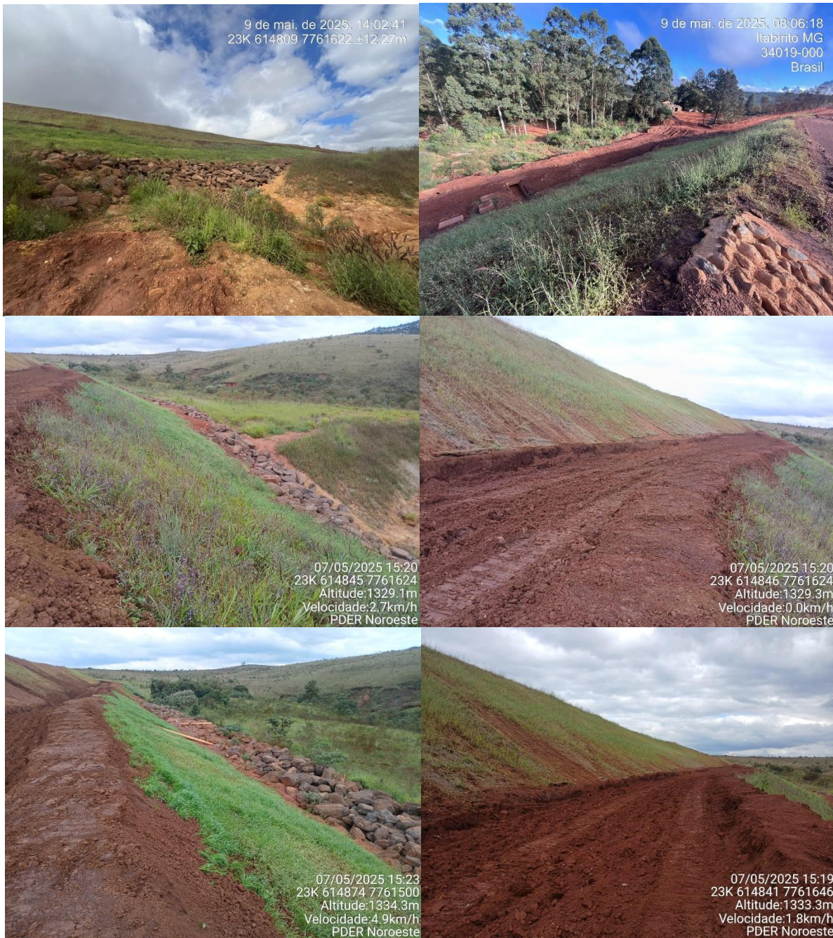
Foto 25: desenvolvimento vegetativo da hidrossemeadura na face do talude (cotas: 1330m a 1340m.).
