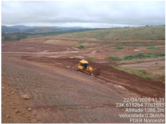
Foto 17: correção de erosão na praça 06 destinada a materiais estéril.
