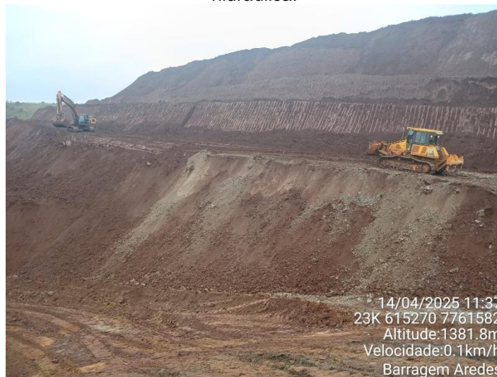
Figura 11: sequência ao retaludamento da praça 10 garantindo maior FS e corrigindo erosões oriundas das chuvas de março.
