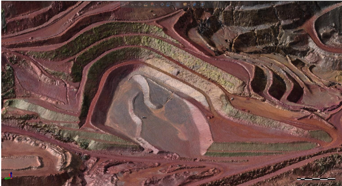
Figura 7: Situação da Aredes após o processo de descaracterização. Meses de abril e maio de 2025, respectivamente.
