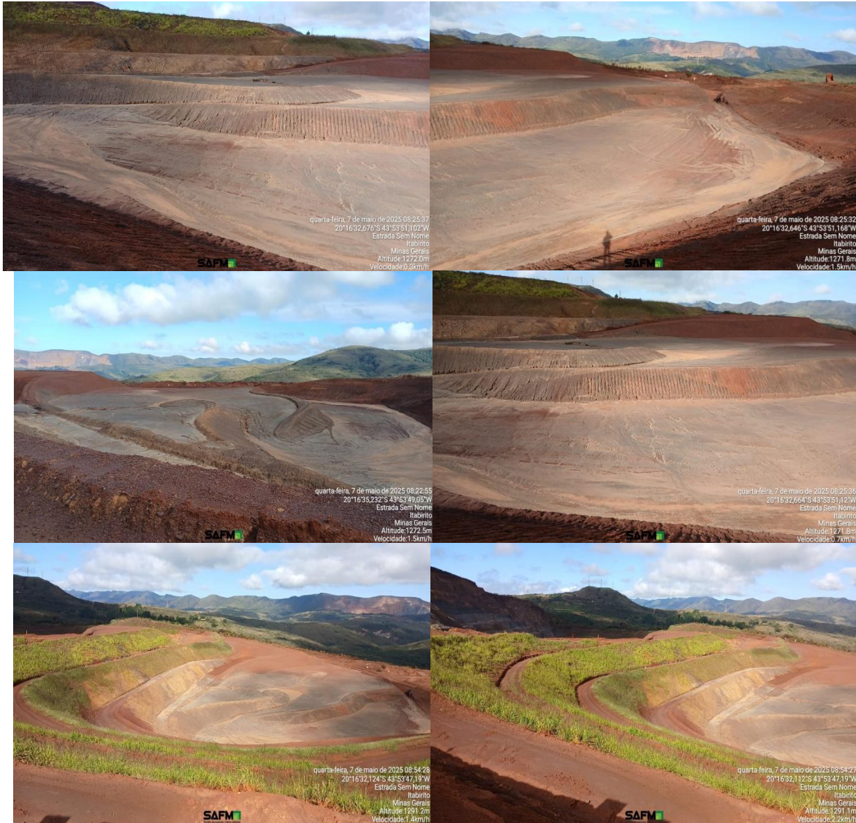
Figura 8: Condição nesse trimestre do antigo barramento e rejeito após a descaracterização.
